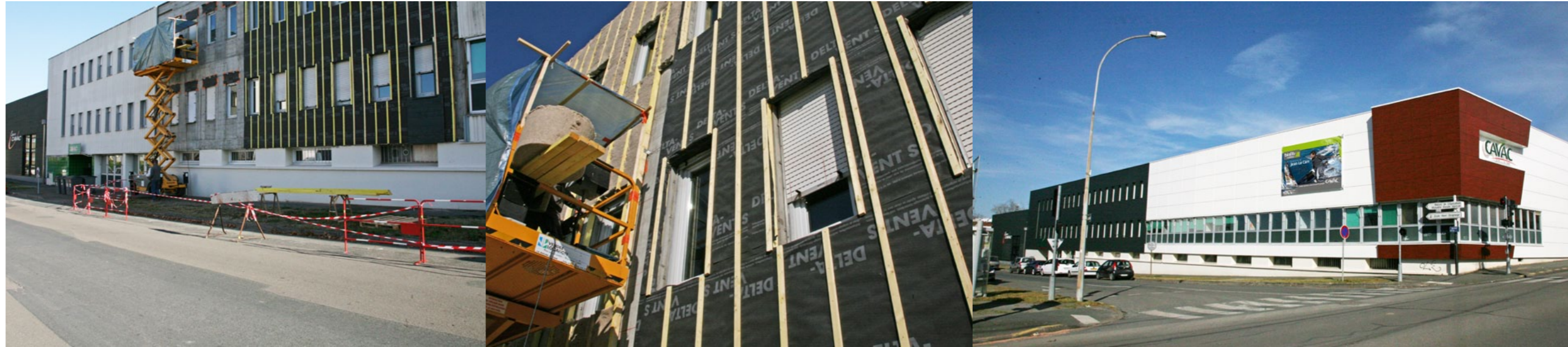
Rénovation par l'extérieur du siège social Cavac avec l'isolant Biofib' duo en panneaux de 400 mm de largeur.
